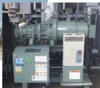
自然冷媒としてアンモニアを使用した冷凍機
